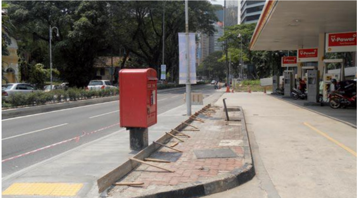
Jalan Raja Chulan menjalani kerja-kerja penambahbaikan laluan pejalan kaki pada tahun 2012
