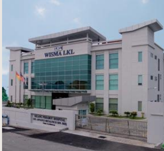
Pembinaan kilang baru LKL di Seri Kembangan
