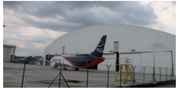
Hangar AIROD Aerospace Technology di Subang
