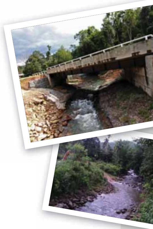
Gambaran sebelum dan selepas pembinaan jalan di Jalan Sugud Timpangoh, Penampang, Sabah
