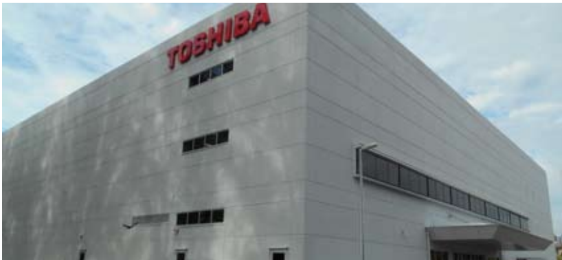
Kilang milik Toshiba di Pulau Pinang
