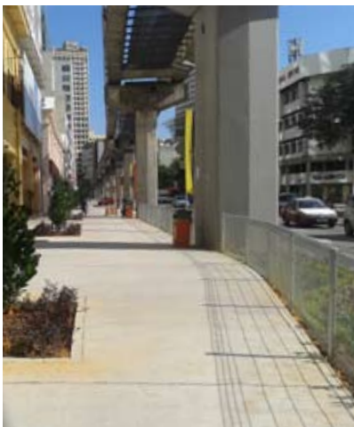
Laluan pejalan kaki sepanjang Jalan Tun Perak
